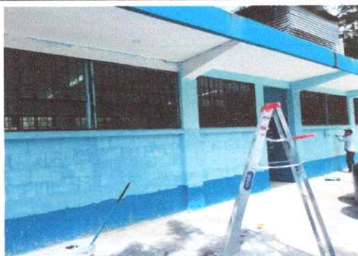
Foto 3: Pintura en muros exterior e interior
