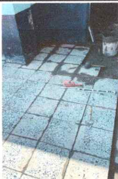
Foto 1: Sustrucción de piso de granito
