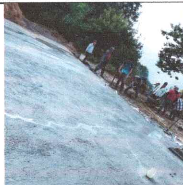
Foto 2: Reparación de piso de torta de concreto
