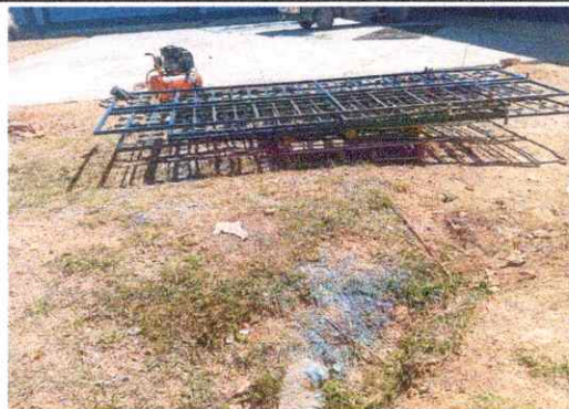
Foto 8: Sustitución de baranda de metal
