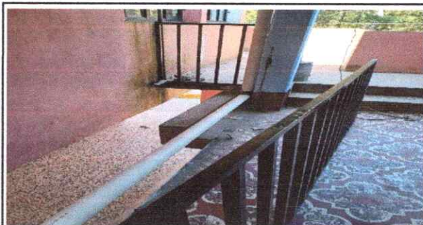
Foto 5: CANALES Y BAJADAS DE AGUAPLUVIAL
