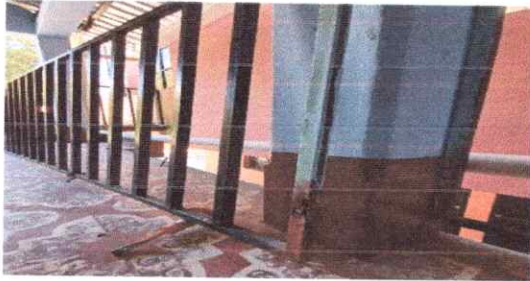
Foto 1: MANTENIMIENTO BARANDAS DE METAL
