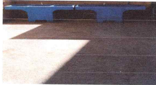
Foto 4: SUSTITUCIÓN DE PILAS DE CONCRETO
