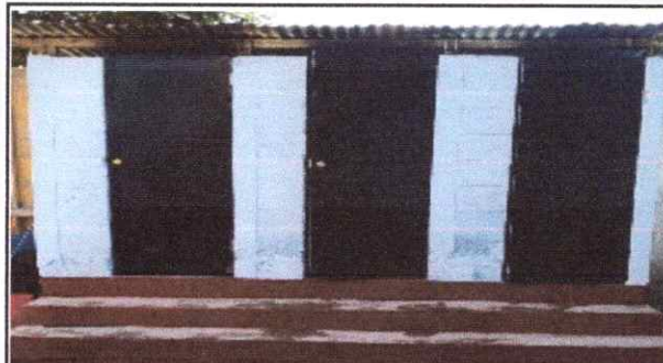
Foto 2: SUSTITUCIÓN DE ESTRUCTURA
