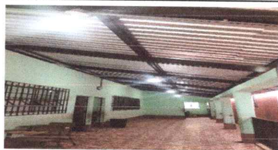
Foto 6: REPARACIÓN DE SISTEMA ELÉCTRICO
