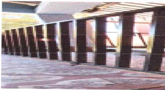
Foto 1: MANTENIMIENTO BARANDAS DE METAL
