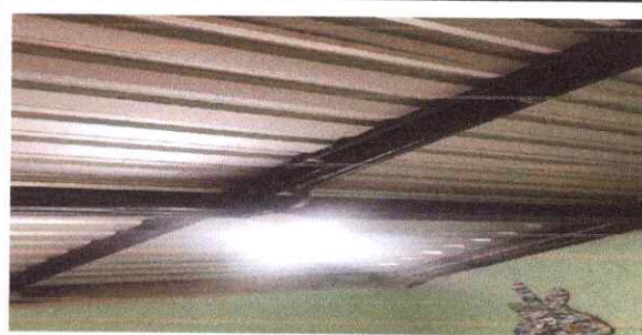
Foto 6: REPARACIÓN DE SISTEMA ELÉCTRICO
