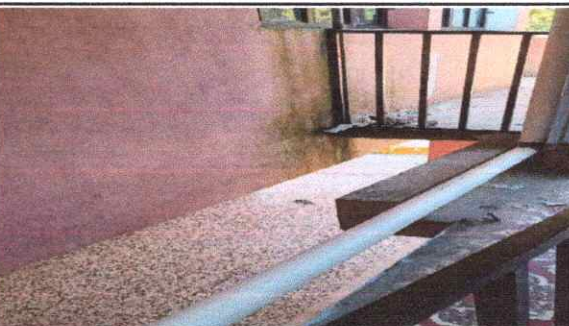
Foto 5: CANALES Y BAJADAS DE AGUAPLUVIAL
