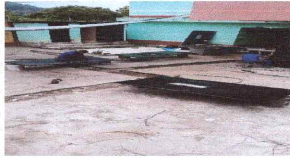
Foto 2: SUSTITUCIÓN DE ESTRUCTURA
