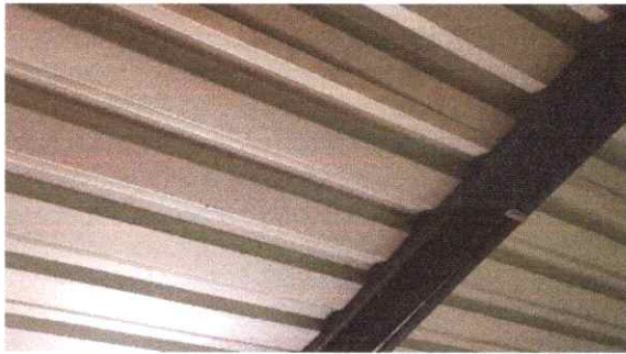
Foto 1: SUSTITUCIÓN DE LAMINA POR LAMINA TROQUELADA
