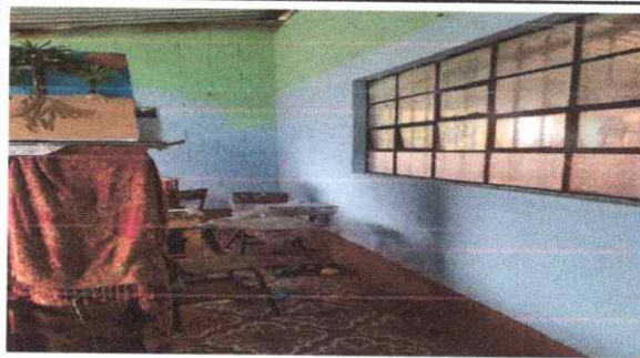
Foto 3: PINTURA DE MUROS EXTERIORES
