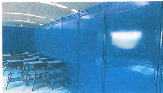
Foto 10: Mantenimiento a estructura de metal de divisiones corredizas (lijado, cepillado y aplicación de pintura anticorrosiva azul)
