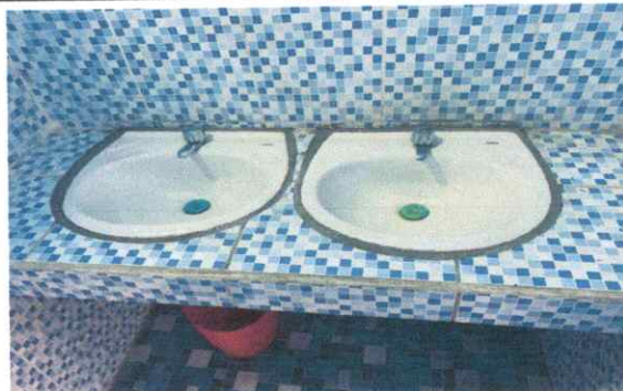
Foto 2: Sustitución de lavamanos
