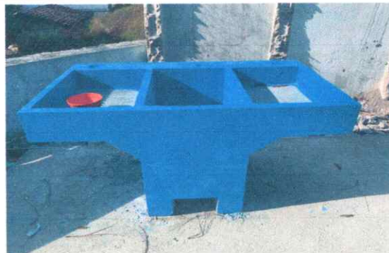
Foto 8: Sustitución de pilas
