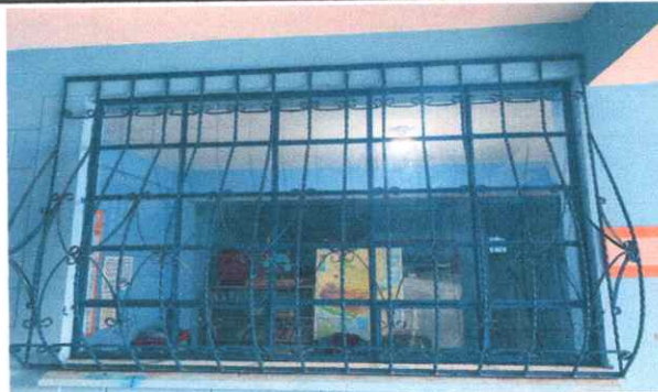
Foto 6: Sustitución de vidrios
