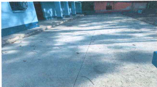
Foto 7: Reparación de plancha de concreto en patio
