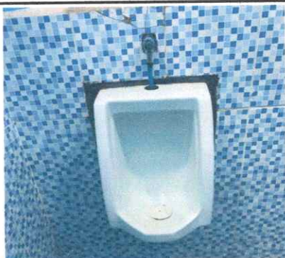
Foto 3: Sustitución de mingitorios
