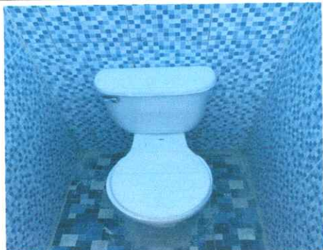
Foto1: Sustitución de inodoros
