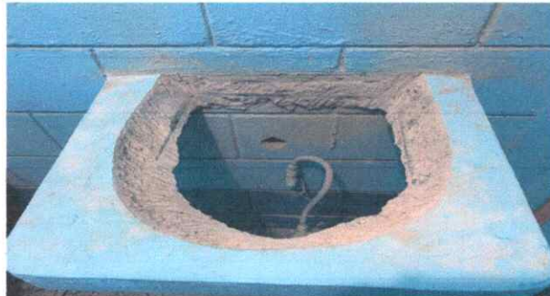
Foto 2: Sustitución de lavamanos
