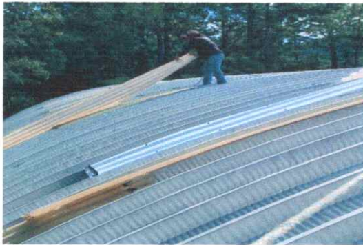
Foto 9: Cambio de lámina tragaluz en techo curvo
