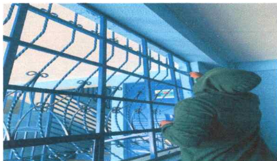
Foto 5: Mantenimiento a estructura de metal de ventanas (lijado, cepillado y aplicación de pintura)
