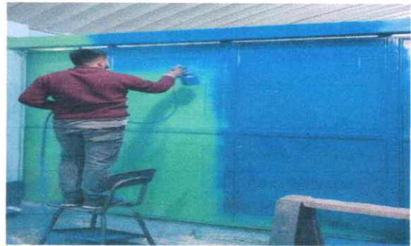
Foto 10: Mantenimiento a estructura de metal de divisiones corredizas
