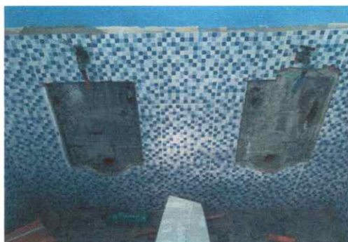
Foto 3: Sustitución de mingitorios
