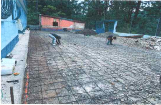
Foto7: Reparación de plancha de concreto en patio
