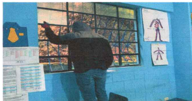
Foto 6: Cambio de vidrios
