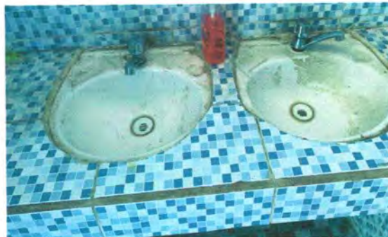
Foto 2: Sustitución de lavamanos
