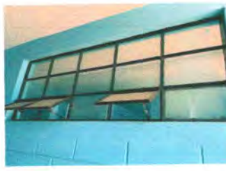
Foto 5: Mantenimiento a estructura de metal de ventanas (lijado, cepillado y aplicación de pintura)
