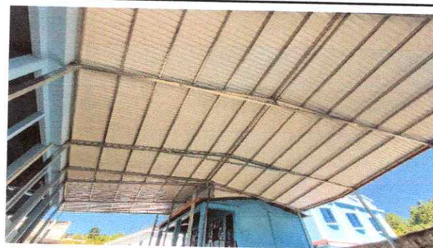
Foto 4: estructura de soporte de metal
