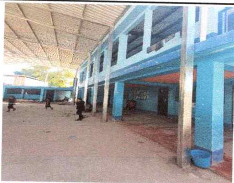
Foto 3: estructura de soporte de metal
