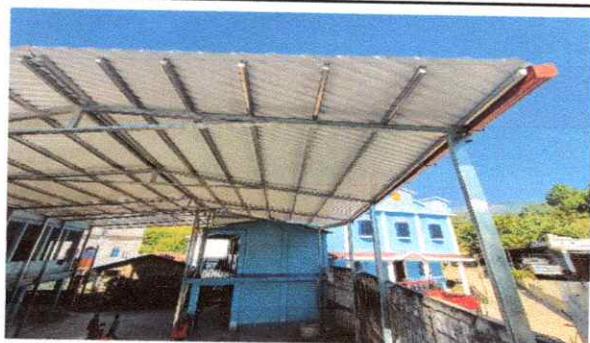
Foto 5: estructura de soporte de metal y techado de lmina troquelada
