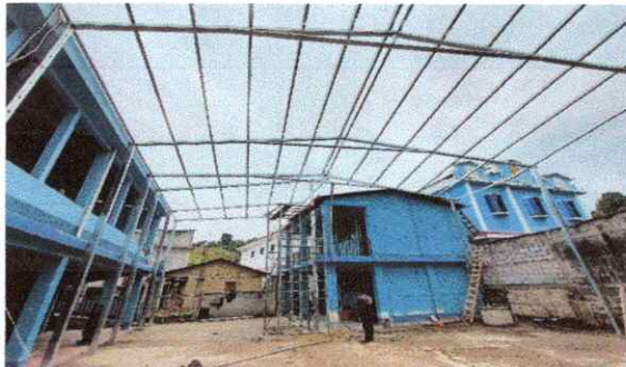
Foto 5: sustitución de estructura de soporte de madera por metal
