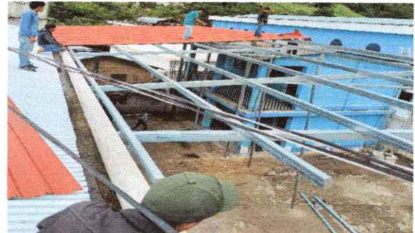
Foto 6: techado de lámina
