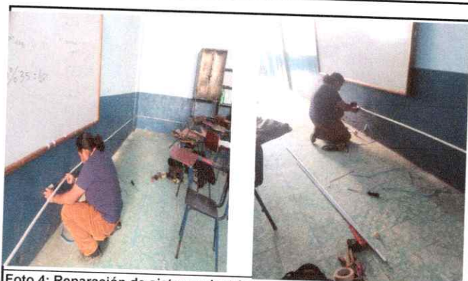
Foto 4: Reparación de sistema electrico
