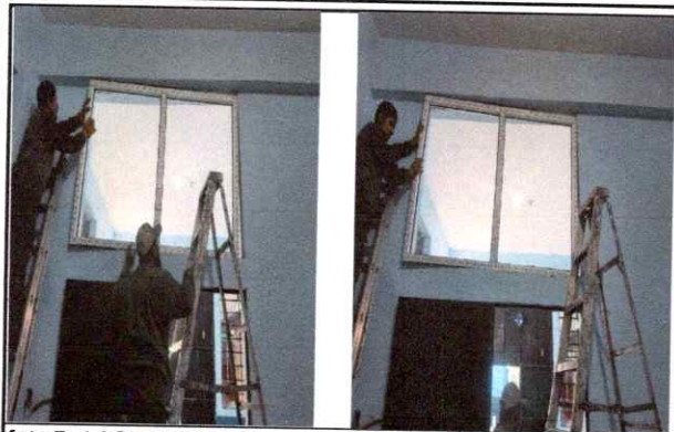
Foto 7: 4.1 Sustitución de ventanas en dirección
