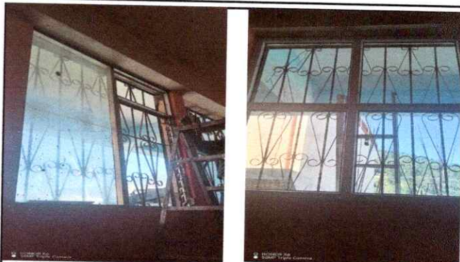
Foto 8:4.2 sustitución de ventanas de aluminio por ventaneria de PVC En corredores.
