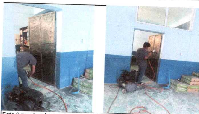
Foto 6 puertas de metal
