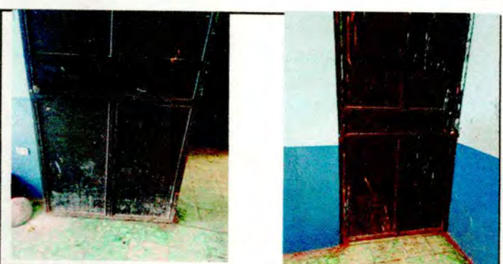
Foto 6: Puertas en mal estado y cambio de chapas en corredor y dirección
