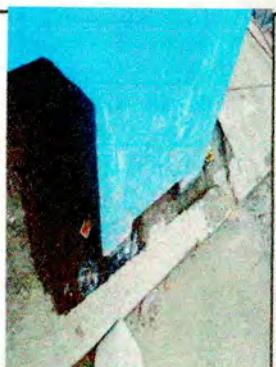
Foto 3: Repello en las paredes por humedad en mal estado
