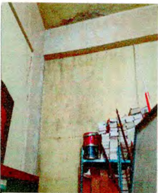
Foto 3: Repello en las paredes por humedad en mal estado
