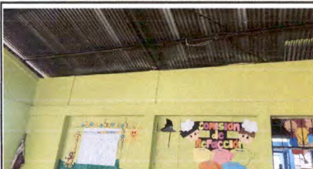
Foto 5: Vista interior del modulo 1, se observa el mal estado de la cubierta de lamina.
