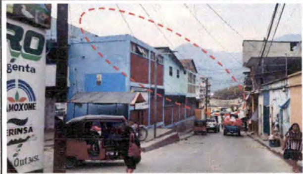
Foto 2: Vista fachada de la escuela, remozar con el cambio de techo.
