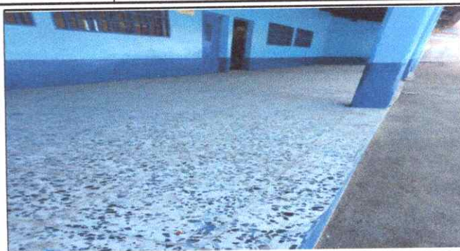
Foto 2: Culminación de piso a granito en los corredores.
