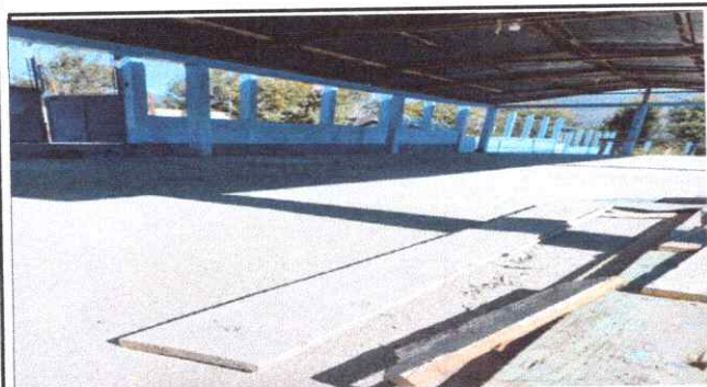
Foto 3: Culminación de piso a torta de Cemento en el salón Escolar
