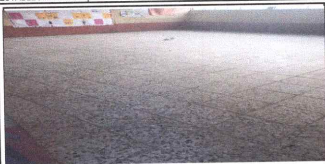
Foto1: Culminación de piso a granito en las aulas
