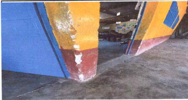
Foto 1: Reparación de piso a granito
