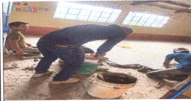
Foto 3: Reparación de piso granito
