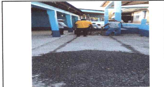
Foto 4: Sustitución de piso a torta Cemento
