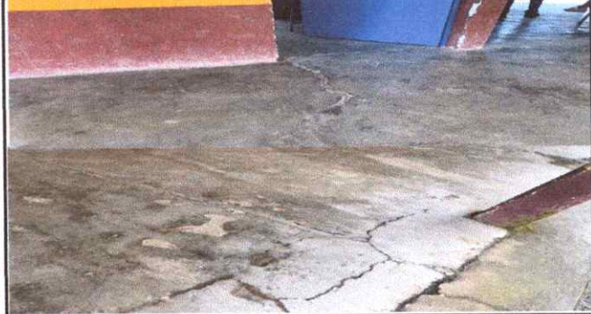
Foto 2: Reparación de piso a granito
