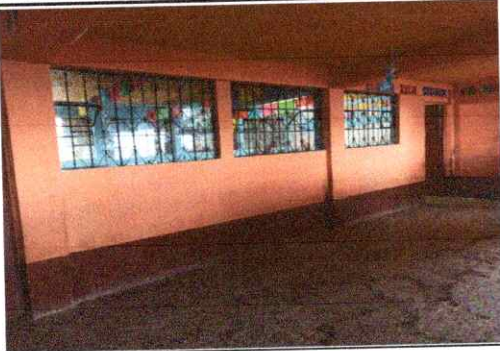
Foto1: Sustitución de ventanales
