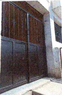
Foto 5: Reparación de portón Segundo Nivel
