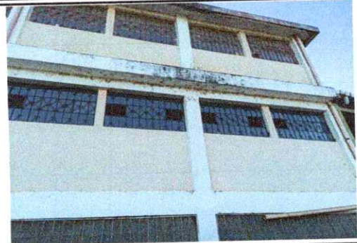
Foto 2: Sustitución de ventanales en segundo nivel
