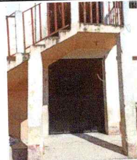
Foto 6: Reparación Portón Primer Nivel
