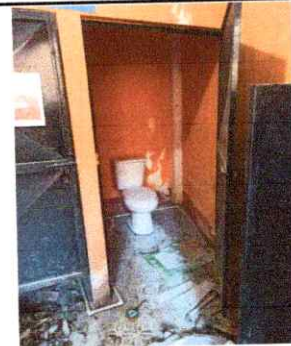
Foto 4: Sustitución de inodoros
