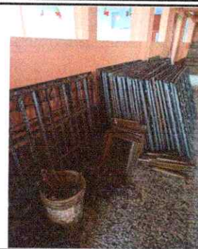
Foto 2: Ventanas a sustituir en segundo nivel
