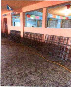
Foto1: Sustrucción de ventanales
