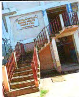
Foto1: Colocación de piso antideslizante hacia segundo nivel
