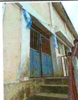
Foto 6: sustitución de portón Segundo Nivel
