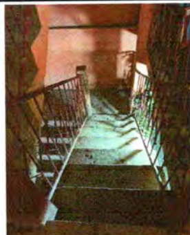
Foto 3: Piso antideslizante para gradas hacia tercer nivel
