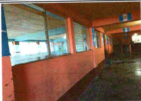
Foto1: Sustitución de ventanas
