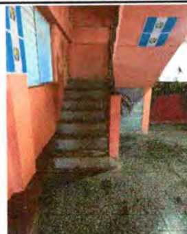
Foto 2: Colocación de piso antideslizante hacia tercer nivel
