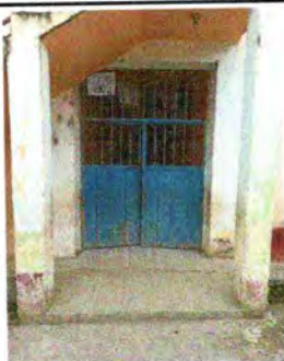
Foto 5: Sustitución de portón Primer Nivel
