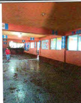
Foto 2: Ventanas a sustituir en segundo nivel interior
