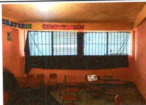
Foto 3: Sustitución de ventanales laboratorio de tecnología
