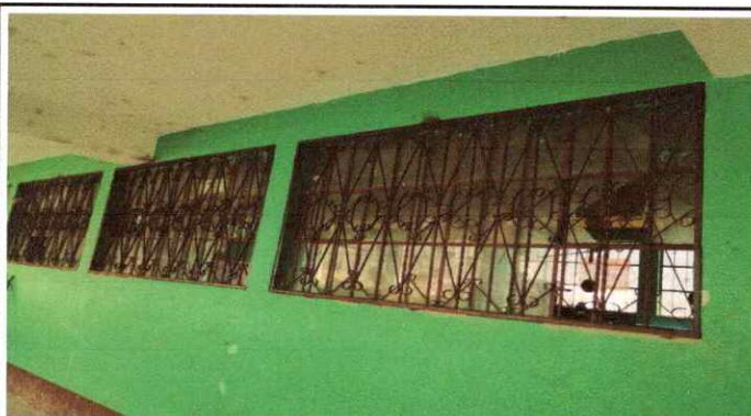
Foto 3: Colocación de balcones de metal
