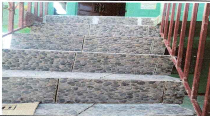
Foto1: Colocación de piso antideslizante en gradas
