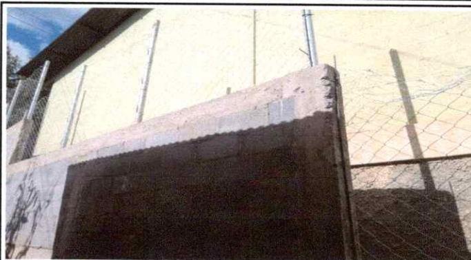
Foto 2: Reparación de muro perimetral
