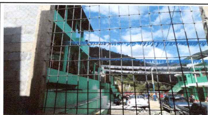
Foto 4: Reparación de muro perimetral (sustitución)
