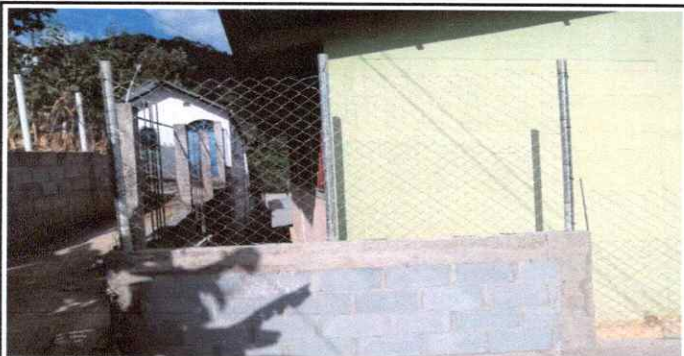
Foto 5: Reparación de muro perimetral
