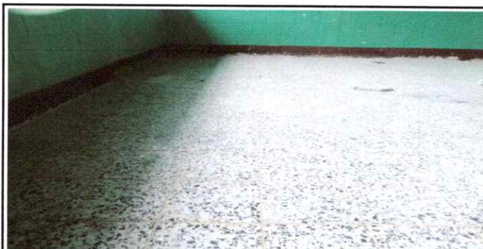
Foto 6: Sustitución de piso de granito
