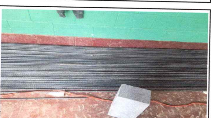
Foto 4: Materiales para la construcción de muro perimetral
