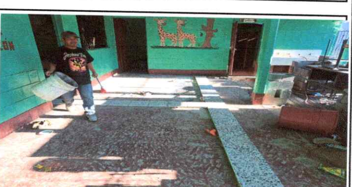
Foto 6: Colocación de piso de granito
