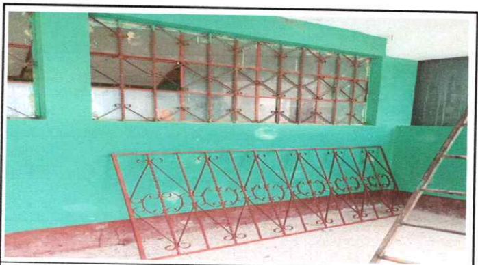
Foto 3: Colocación de balcones de metal
