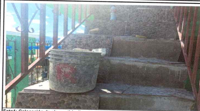
Foto 1: Colocación de piso antideslizante en las gradas
