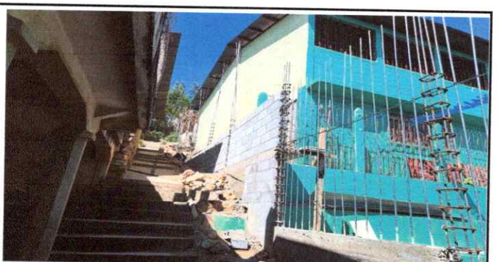
Foto 5: Construcción del muro perimetral
