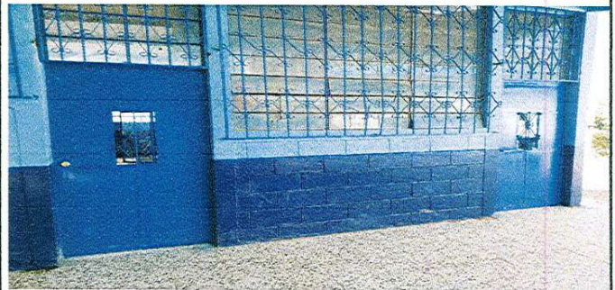
Foto2: Sustitución de puertas de metal
