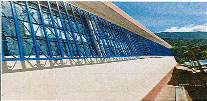
Foto 3: Fabricación e Instalación de balcones en ventanas
