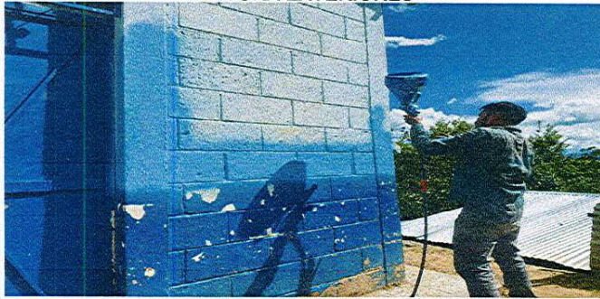
Foto 5: Pintura en aulas exterior
