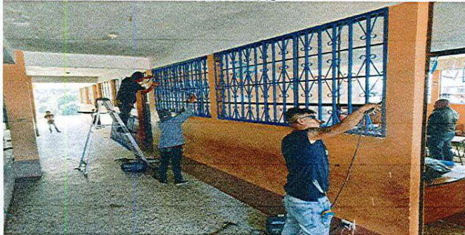
Foto 3: Fabricación e Instalación de balcones en ventanas
