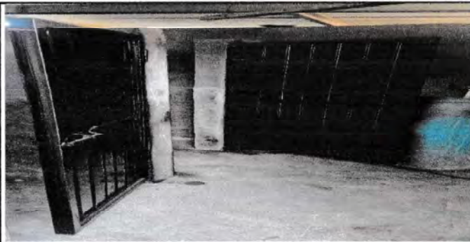
Foto 1: REMOZAMIENTO EN PINTURA DE PUERTAS DE BAÑO
