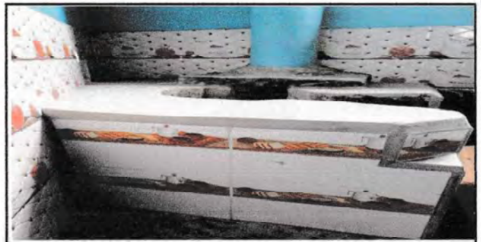
Foto 4: REPARACIÓN DE ESTUFA RURAL EN MODULO DE PRIMARIA
