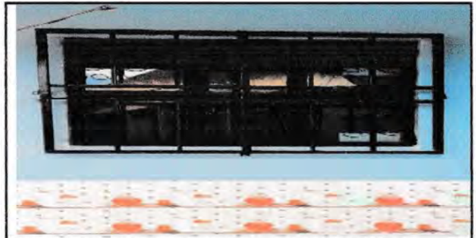
Foto 4: SUSTITUCIÓN DE VENTANAS Y BALCONES METALICAS
