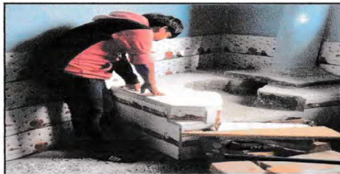
Foto 4: REPARACIÓN DE ESTUFA RURAL EN MODULO DE PRIMARIA
