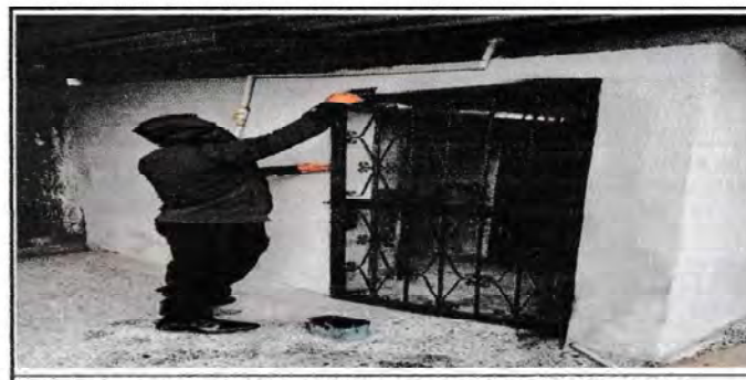
Foto 6: REMOZAMIENTO DE PINTURA EN PUERTAS TIPO BARANDA
