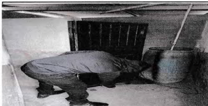
Foto 1: REMOZAMIENTO EN PINTURA DE PUERTAS DE BAÑO
