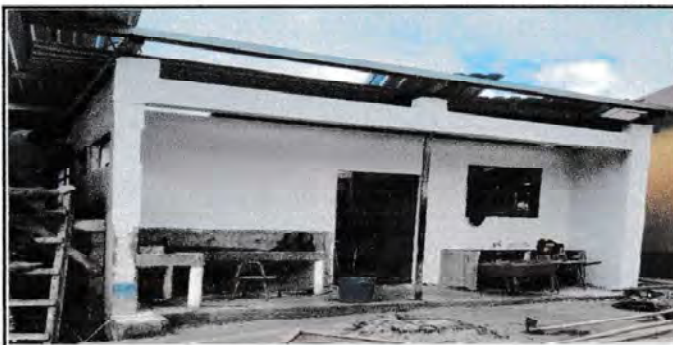
Foto 3: SUSTITUCIÓN DE LAMINA TROQUELADA EN MODULO DE PRIMARIA DE ALDEA EL GRANADILLO
