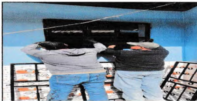
Foto 4: SUSTITUCIÓN DE VENTANAS Y BALCONES METÁLICAS
