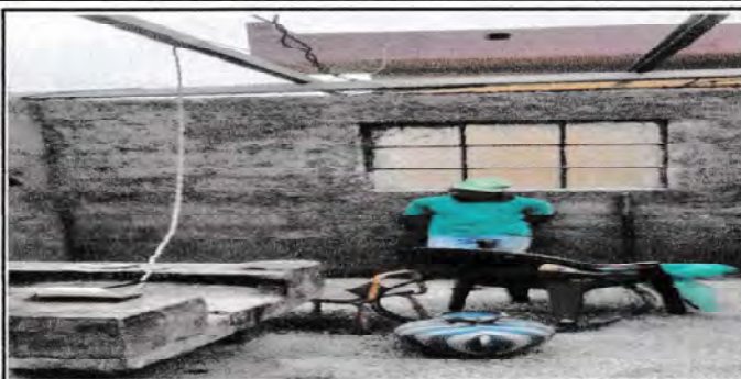
Foto 1: REPARACIÓN DE REPELLO Y CERNIDO EN PAREDES EN MODULO DE COCINA DE PRIMARIA DE ALDEA EL GRANADILLO
