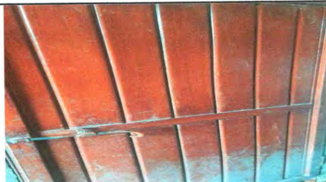
FOTO 4: REMOZAMIENTO EN PINTURA DE PUERTAS DE BAÑOS
