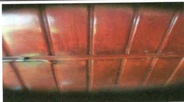
FOTO 3: REMOZAMIENTO EN PINTURA DE PUERTAS DE BAÑOS
