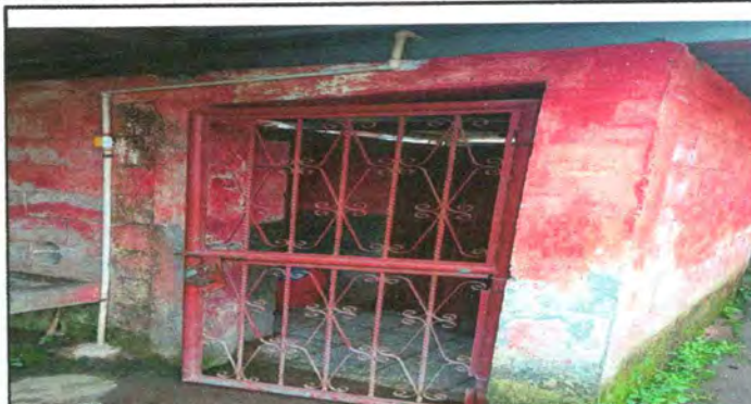
FOTO 2: REMOZAMIENTO DE PINTURA EN PUERTA TIPO BARANDA
