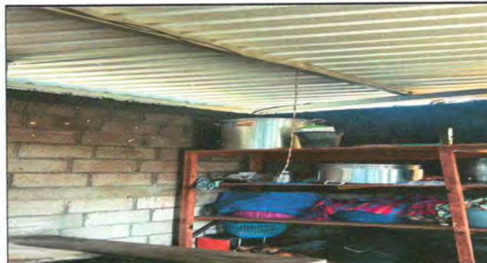
Foto 4: SUSITUCIÓN DE LAMINA TROQUELADA EN MODULO DE PRIMARIA DE ALDEA DE EL GRANADILLO
