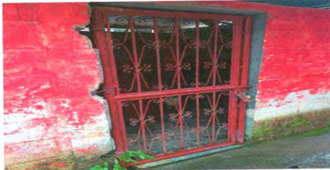
FOTO 1: REMOZAMIENTO DE PINTURA EN PUERTA TIPO BARANDA
