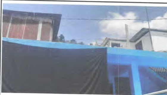
Foto 9: Vista del modulo 1, se observa aula.
