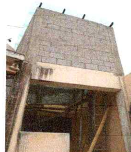
Foto 2: Mejoramiento de muro y lámina para techo
