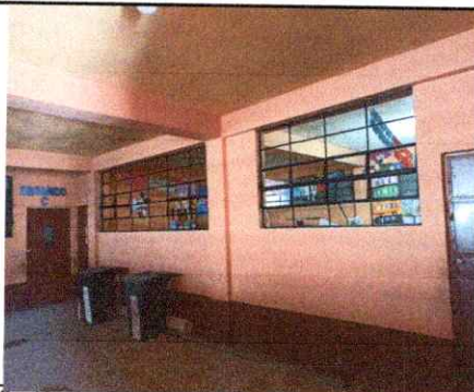
Foto 3: Sustitución de vidrios ventanales primer nivel
