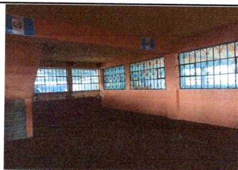
Foto 5: Sustitución de ventanas y vidrios
