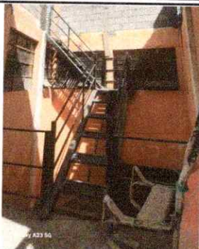
Foto1: Estructura metal para gradas
