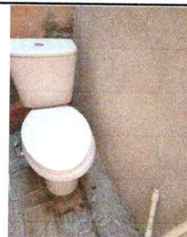
Foto 6: Sustitución de inodoro
