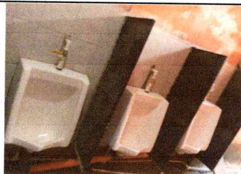
Foto 4: Sustitución de mingitorios
