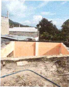
Foto 3: Sustitución de lámina para techo acceso tinaco
