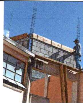
Foto 2: Mejoramiento de muro para techo
