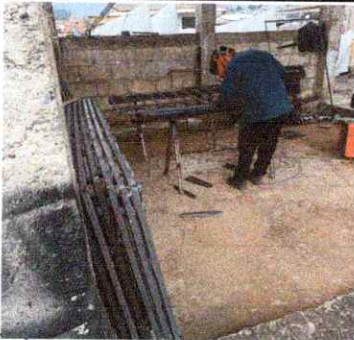
Foto 5: Sustitución de ventanas y vidrios
