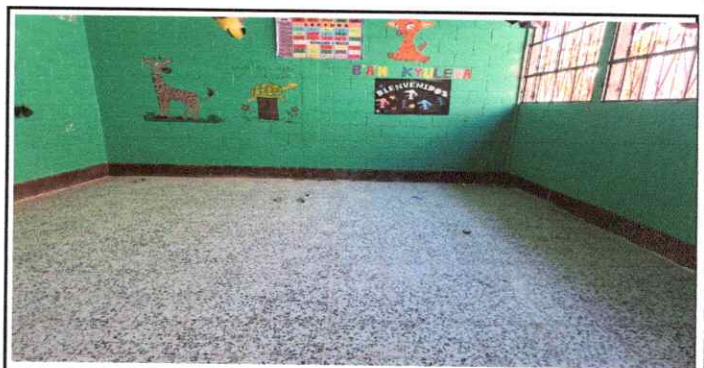
Foto 6: Se colocó piso de granito en las aulas de la planta alta, primer nivel
