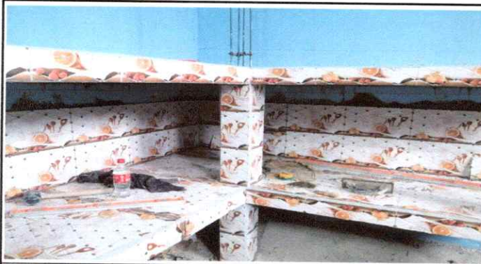
Foto 3: Se construyeron planchones y colocación de azulejo en la cocina
