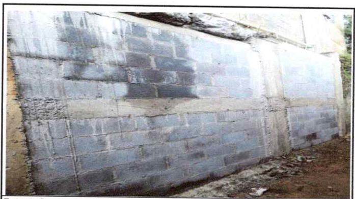
Foto 4: Se construyó el muro de contención en la parte de atrás de las aulas planta alta.
