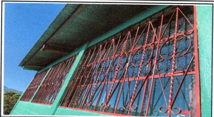
Foto 2: Se colocaron ventanas y balcones en las aulas de la planta alta
