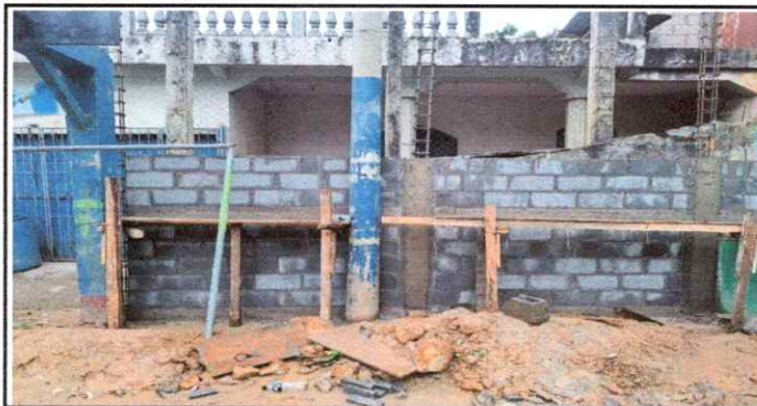
Foto 5: Reparación de muro perimetral
