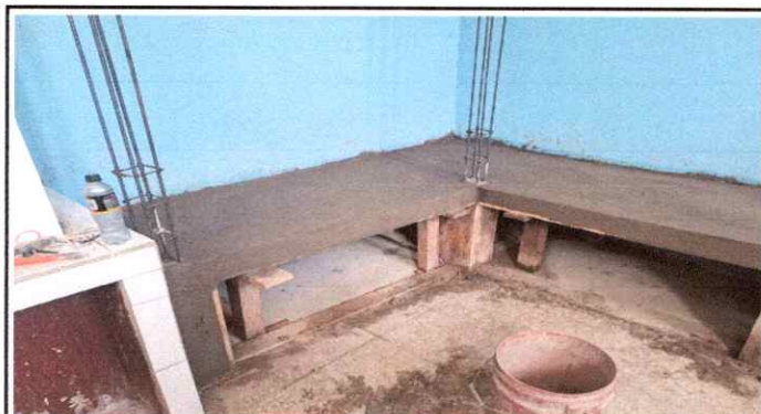
Foto 3: Colocación de planchones para colocación de utensilios de cocina
