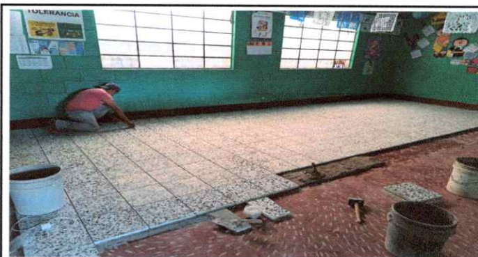
Foto 6: Sustitución de piso de granito
