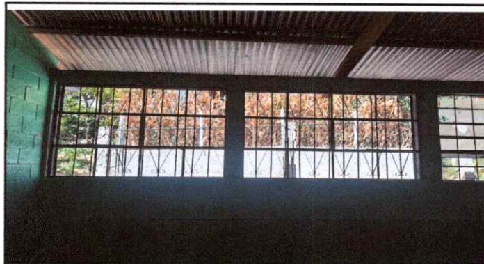
Foto 1: Colocación de ventanas y balcones
