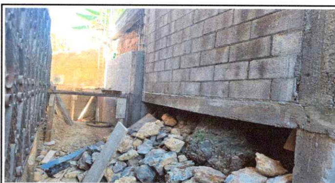
Foto 4: Reparación de muro de contención
