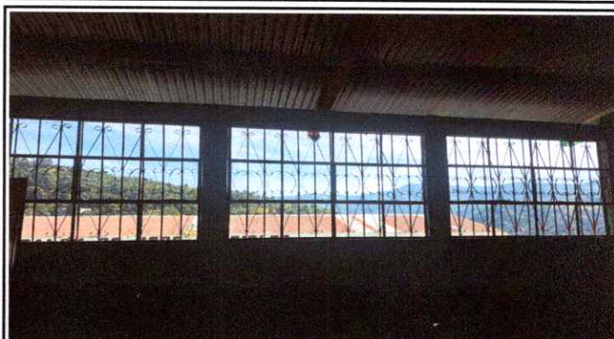
Foto 2: Colocación de ventanas y balcones
