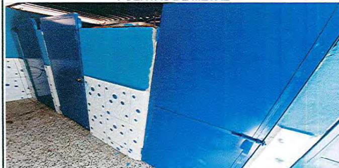
Foto 4: Sustitución de puertas en servicios sanitarios
