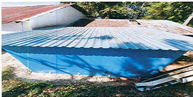
Foto 1: Sustitución de techo de lámina
