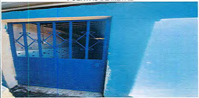
Foto 5: Sustitución de puerta principal para baños
