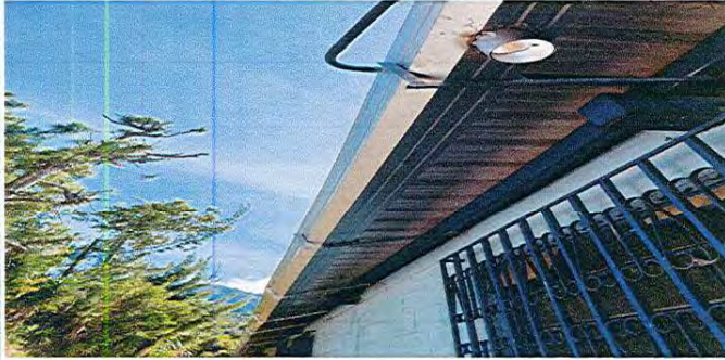
Foto 1: Sustitución de canal de PVC por canal de metal con sujeción
