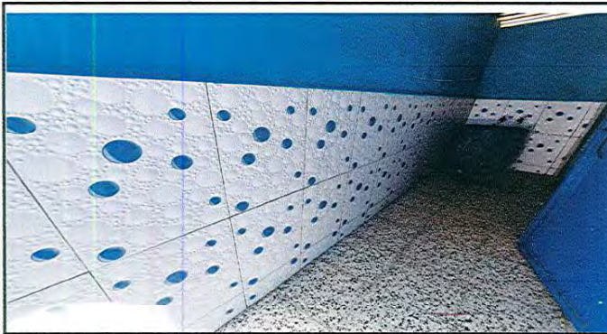
Foto 3: Instalación de Azulejo para baños
