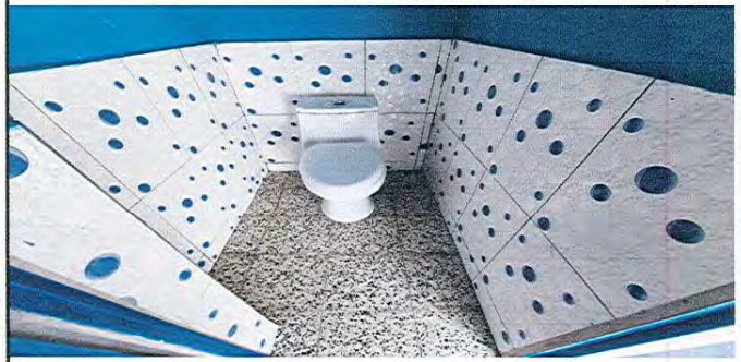
Foto 2: Sustitución de tasas para baños lavables
