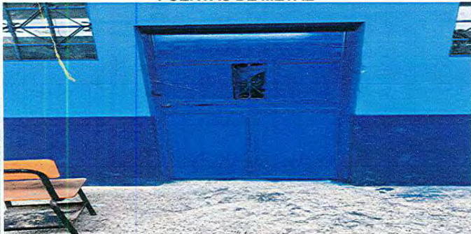
Foto 3: Mantenimiento a puertas de metal, lijado y pintado, de 5 aulas.
