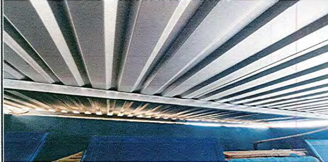
Foto 2: Sustitución de estructura de soporte de madera
