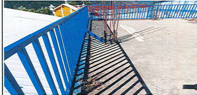
Foto 4: Instalación de barandas de metal
