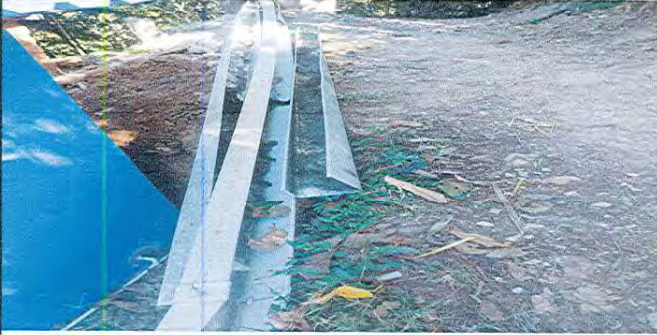
Foto 1: Sustitución de canal de PVC por canal de metal con sujeción
