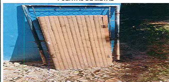
Foto 5: Sustitución de puerta principal para baños
