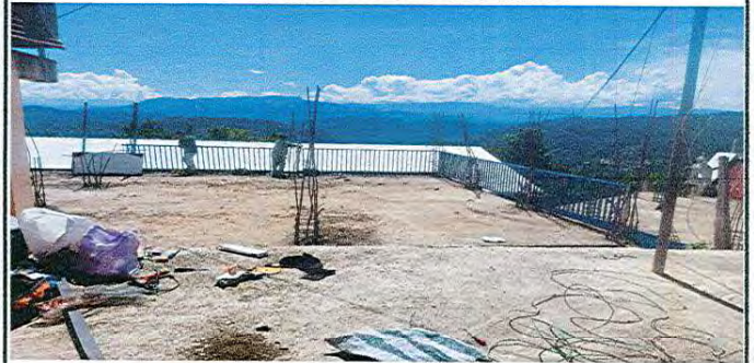
Foto 4: Instalación de barandas de metal
