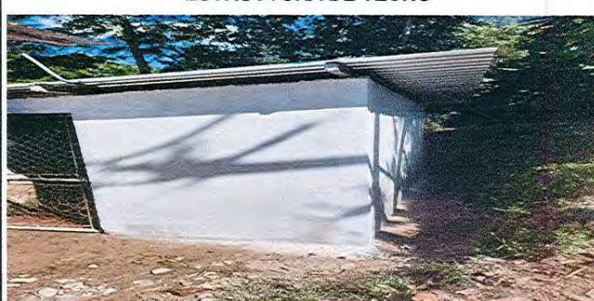
Foto 2: Sustitución de estructura de soporte de madera
