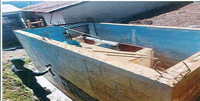
Foto1: Sustitución de techo de lámina
