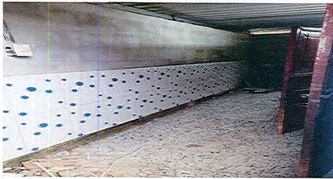
Foto 3: Instalación de Azulejo para baños
