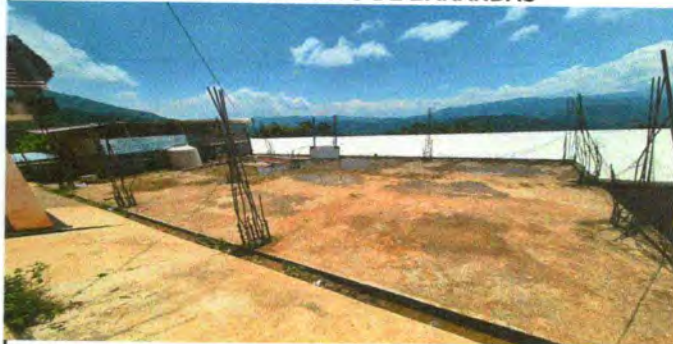
Foto 4: Instalación de barandas de metal
