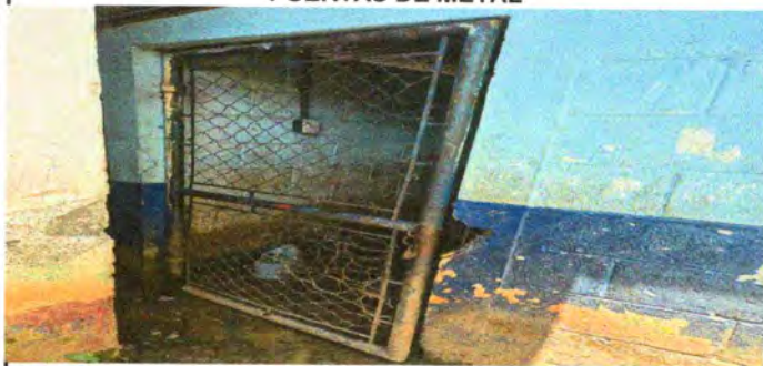
Foto 5: Sustitución de puerta principal para baños
