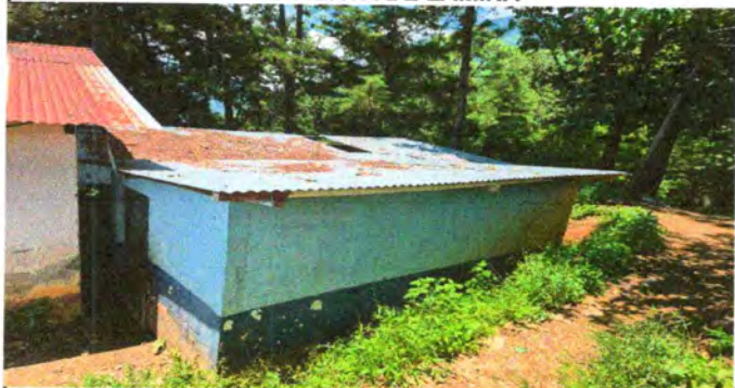
Foto1: Sustitución de techo de lámina
