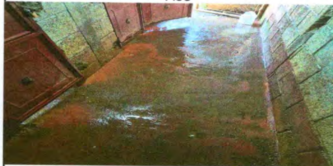
Foto 6: Sustitución de piso de torta de concreto por piso de granito
