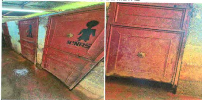
Foto 4: Sustitución de puertas en servicios sanitarios
