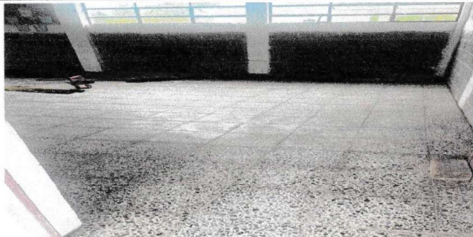
FOTO 2: SUSTITUCIÓN DE PISO DE TORTA POR PISO DE GRANITO EN MODULO DE PRE-PRIMARIA DE ALDEA EL GRANADILLO
