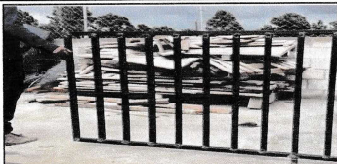
FOTO 1: SUSTITUCIÓN DE BARANDAS DE METAL EN MODULOS DE PRE-PRIMARIA DE ALDEA EL GRANADILLO
