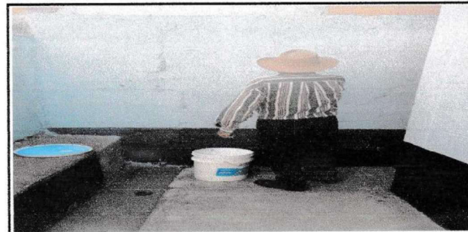
FOTO 6: PINTURA EN MUROS EXTERIORES
