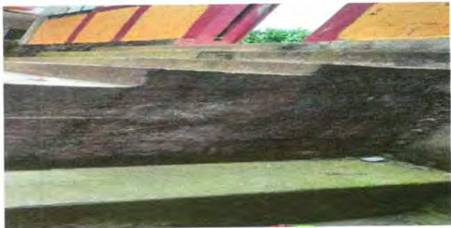
FOTO 1 : PINTURA EN MUROS EXTERIORES
