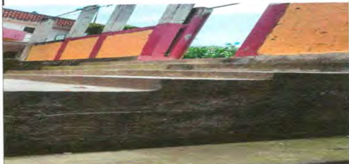
FOTO 2 : PINTURA EN MUROS EXTERIORES
