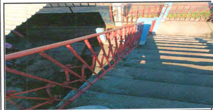
Foto 5: SUSTITUCIÓN DE BARANDAS DE METAL EN MODULO DE PRE-PRIMARIA DE ALDEA EL GRANADILLO
