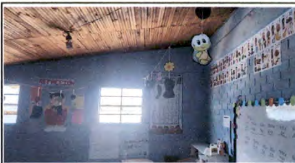
Foto 6: Vista interior de las aulas del modulo 2, se observa el mal estado del machimbre debido a las filtraciones de la cubierta de lamina.
