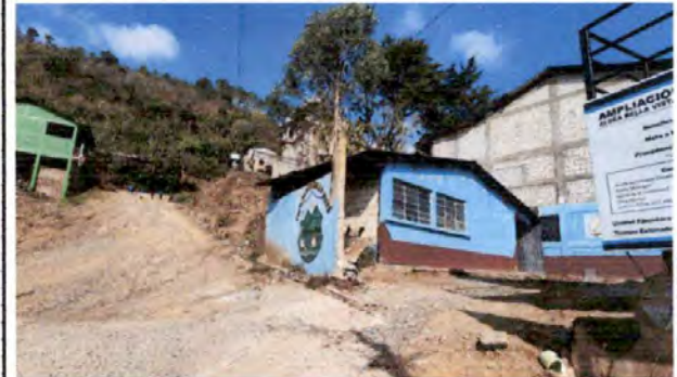
Foto 2: Vista del ingreso y de la cocina a remozar, en el ingreso se levantarán columnas y se colocará una puerta de ingreso.
