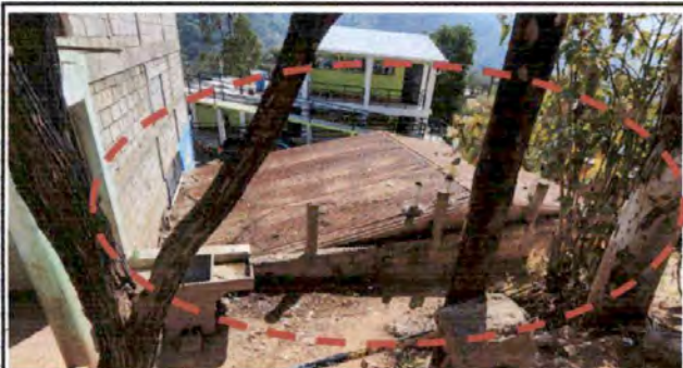
Foto 9: Se levantará con block esta parte del muro perimetral, para evitar que se dañe la lamina al momento de cambiarla.
