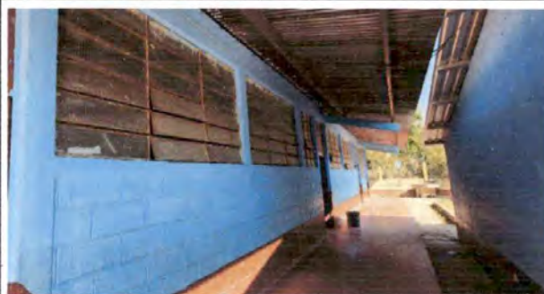
Foto 10: Vista del modulo 1 se observan las ventanas de la parte de enfrente.
