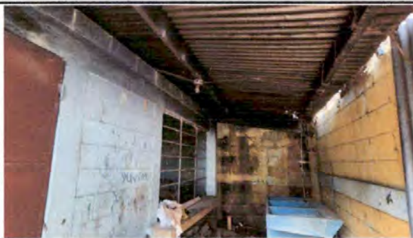
Foto 5: Vista del pasillo la mina en mal estado, necesario colocar un canal metálico.
