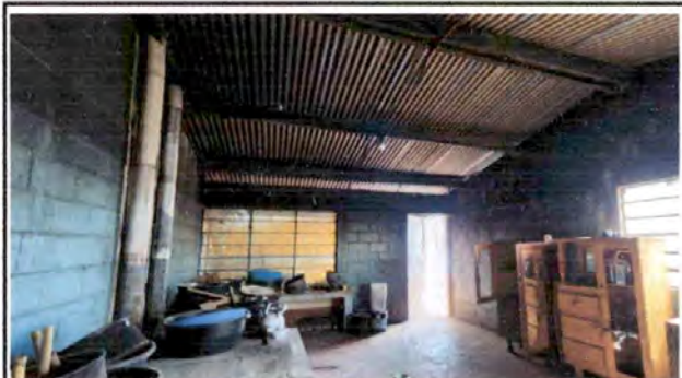
Foto 6: Vista del interior de la cocina se remozará el piso, se colocará el azulejo en paredes y cambio del sistema eléctrico.
