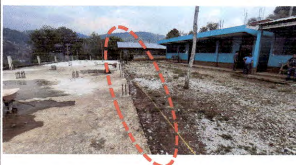
Foto 4: Vista de la ubicación donde estará el canal de desfogue de agua pluvial.
