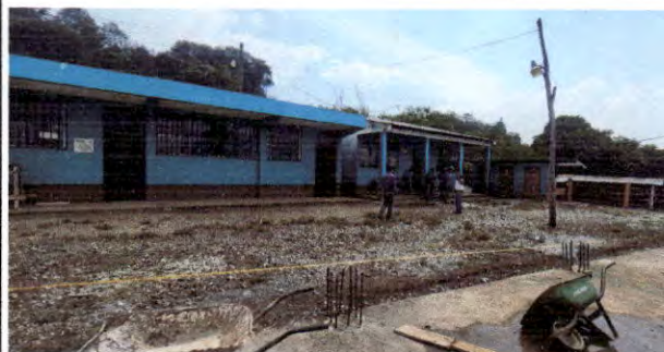
Foto 2: Vista del modulo 2 y 3, enfrente esta el patio el cual se remozará.
