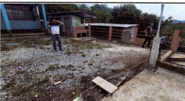
Foto 6: Vista del patio, ahí se realizará remozamiento.
