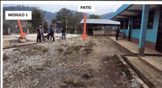
Foto 3: Vista del modulo 1, enfrente esta el patio el cual se remozará.
