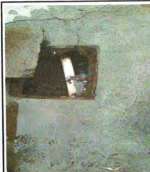
Foto 12: CAJA DE REGISTRO EN MAL ESTADO
