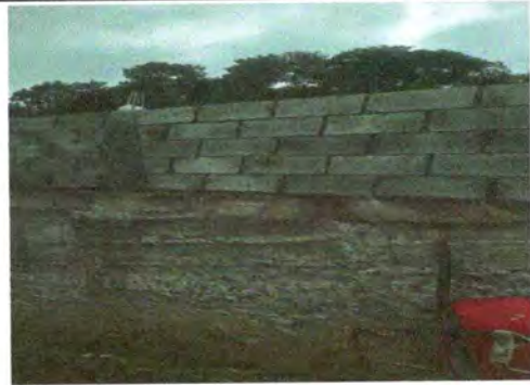
Foto 8: REPELLO EN MURO DE CONTENCIÓN
