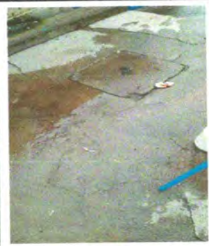
Foto 12: CAJA DE REGISTRO EN MAL ESTADO
