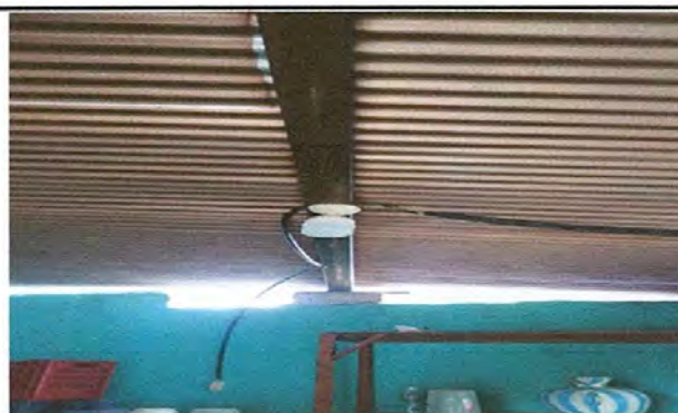
Foto 6: SUSTITUCION DE SISTEMA ELECTRICO
