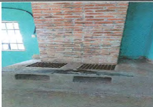
Foto 1: SUSTITUCION DE ESTUFAS
