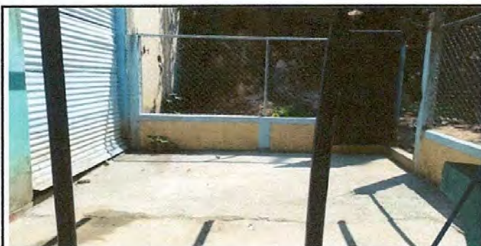
Foto 5: COLOCACION DE TORTA
