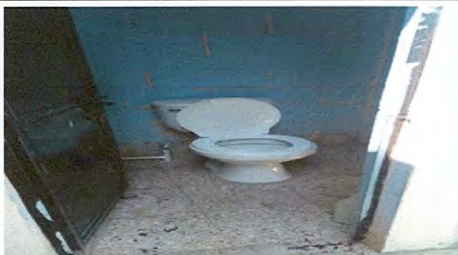
Foto 3: SUSTITUCION DE INODORO
