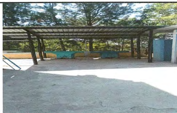
Foto 4: SUSTITUCION DE LAMINA Y ESTRUCTURA PORTANTE
