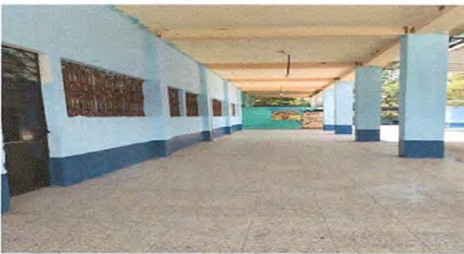
Foto 3: PINTADO INTERIOR Y EXTERIOR
