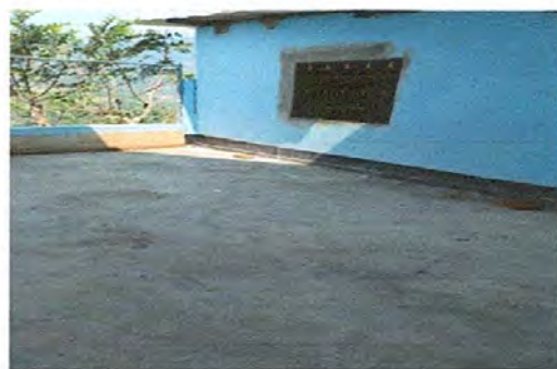
Foto 4: SUSTITUCION DE VENTANAS
