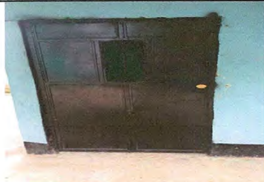
Foto 2: SUSTITUCION DE PUERTA
