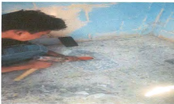
Foto 3: SUSTITUCION DE INODORO
