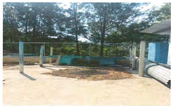
Foto 4: SUSTITUCION DE LAMINA Y ESTRUCTURA PORTANTE
