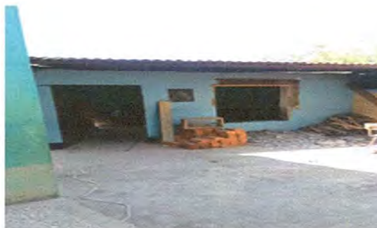
Foto 4: CAMBIO DE VENTANAS
