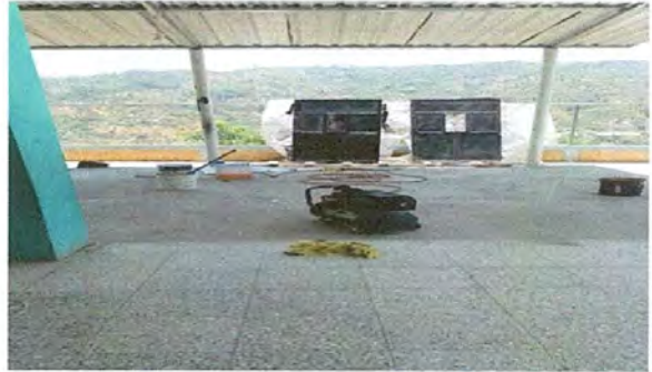
Foto 2: SUSTITUCION DE PUERTAS
