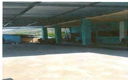
Foto 6: SUSTITUCION DE SISTEMA ELECTRICO
