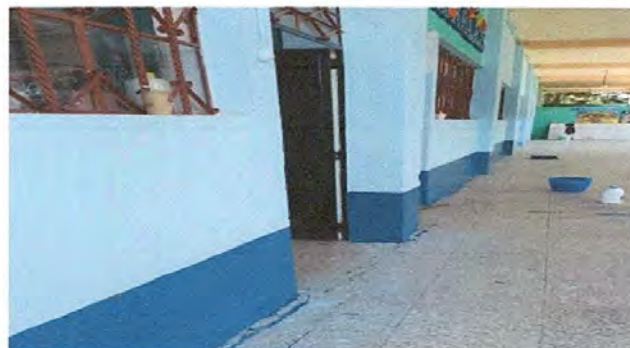
Foto 6: SUSTITUCION DE TUBERIAS
