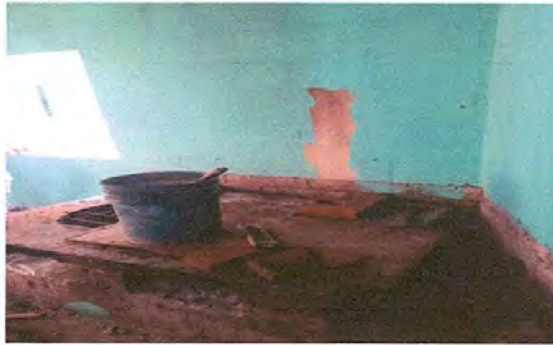
Foto 1: SUSTITUCION DE ESTUFAS
