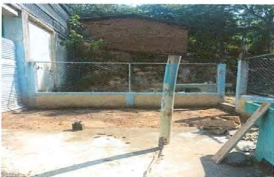
Foto 5: COLOCACION DE TORTA
