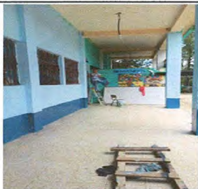
Foto 3: PINTADO INTERIOR Y EXTERIOR
