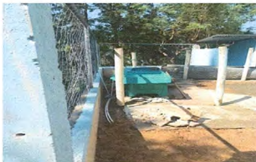
Foto 2: CAMBIO DE TUBERIA Y SISTEMA DE DRENAJE
