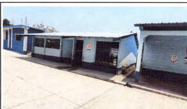
Foto 3: Se observa la cocina, la cual se pretende remozar.
