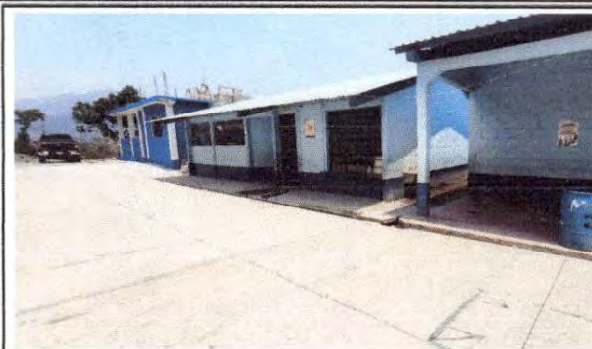
Foto 2: vista del área de cocina.
