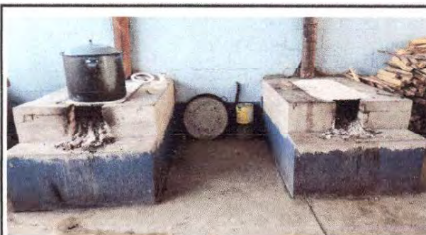
Foto 5: Estufas mejoradas en mal estado.
