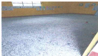
Foto 1: Sustrucción de piso en granito
