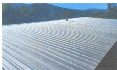
Foto 4: cambio de techo de cocina y baños
