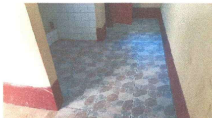
Foto 2: sustrucción de piso antideslizante
