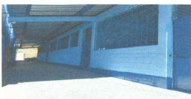
Foto 5: pintada de paredes
