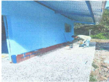
Foto 5: pintada de paredes
