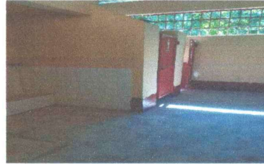
Foto 2: sustitución de piso antideslizante
