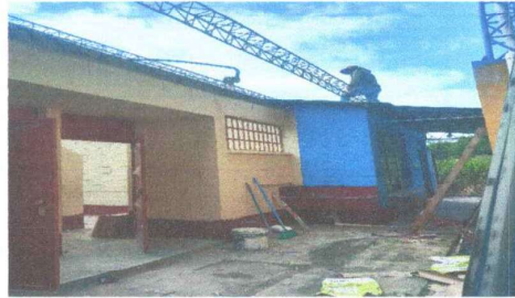
Foto 4:cambio de techo de cocina y baños
