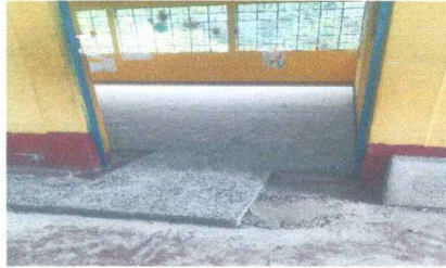
Foto 1: Sustitución de piso en granito
