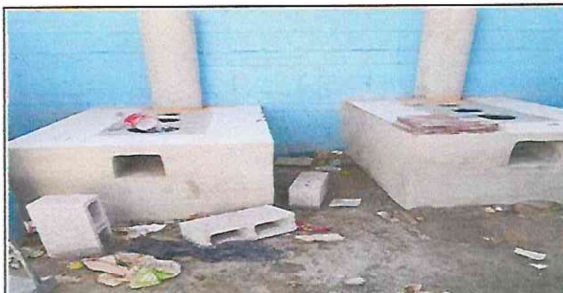
Foto 4: SUSTITUCION DE PLANCHA DE COCINA Y CHIMENEA
