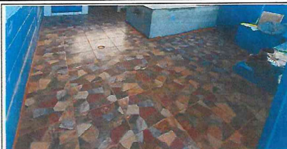
Foto 2: SUSTITUCION DE PISO DE CONCRETO (POR PISO ANTIDESLIZANTE)
