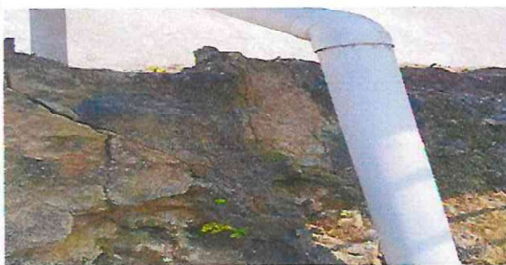
Foto 5: SUSTITUCION DE CANALES Y BAJADAS DE AGUA
