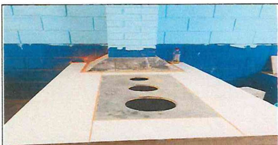
Foto 3: SUSTITUCION DE CERAMICO PARA ESTUFA ( AZULEJO )
