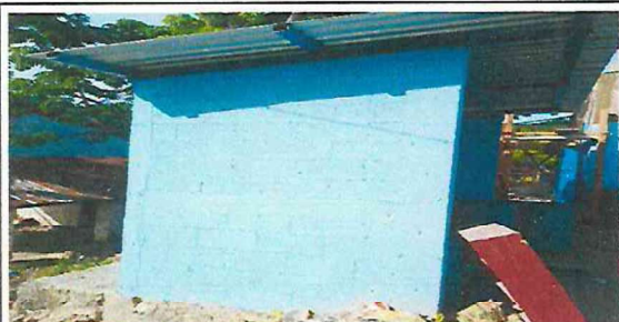
Foto1: MEJORAMIENTO DE MURO COCINA 5 HILADAS DE BLOCK
