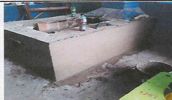
Foto 3: SUSTITUCION DE CERAMICO PARA ESTUFA ( AZULEJO )
