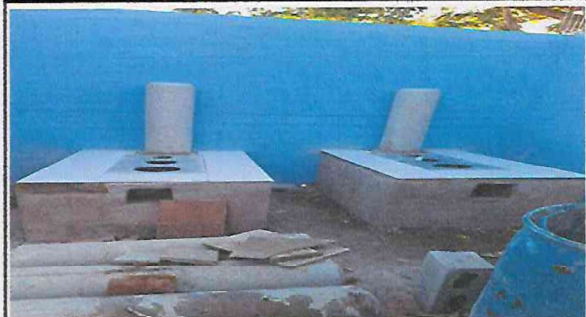
Foto 4: SUSTITUCION DE PLANCHA DE COCINA Y CHIMENEA
