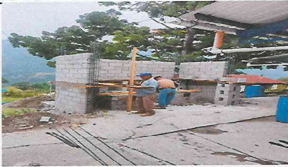
Foto1: MEJORAMIENTO DE MURO COCINA 5 HILADAS DE BLOCK
