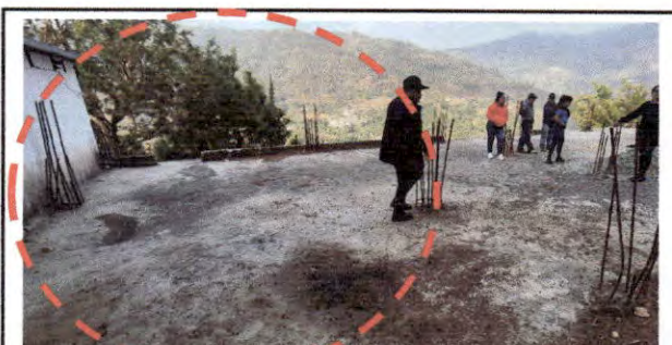
Foto 6: área donde se levanta muro de block, además se colocara en todo el perímetro para evitar algún accidente con los niños.
