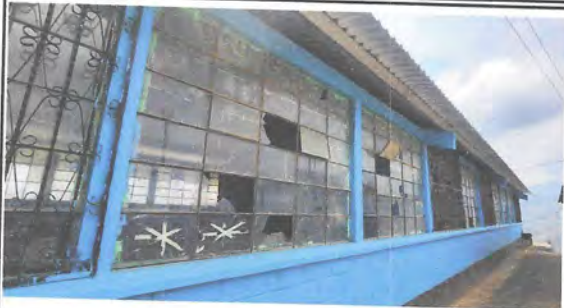
Foto 7: Vista parte de atrás de modulo 1, se observan 9 ventanas, las cuales se cambiarán y también se colocarán 6 balcones.
