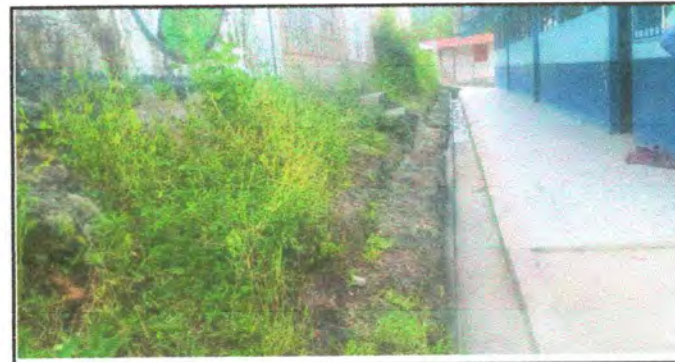
Foto 6: Mejoramiento de patio de las aulas módulo I
