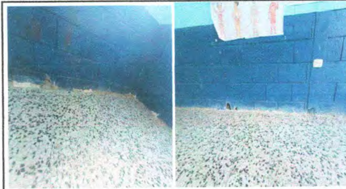
Foto 2: MEJORAMIENTO: Zócalo (piso) en las paredes del módulo I. 128 mts2
