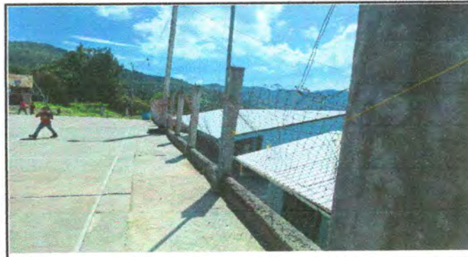
Foto 4: Reparación de malla con tubo hg galvanizada 49 ML
