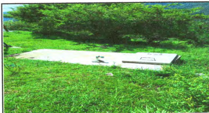
Foto 4: Limpieza en fosa séptica 2
