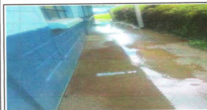
Foto 5: Mejoramiento patio de concreto módulo 2
