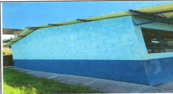
Foto 2: Pintura en aulas módulo II
