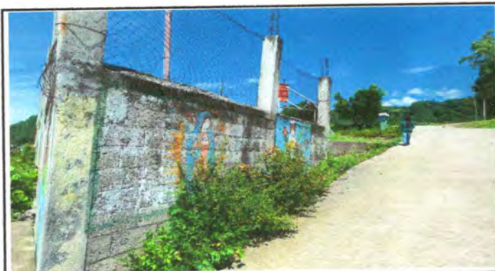
Foto 3: Mejoramiento de muro de repello muro de contencion
