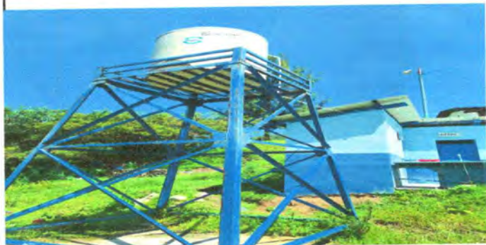
Foto 1: Mantenimiento de la base del tinaco y sustitución de accesorios depósito de agua
