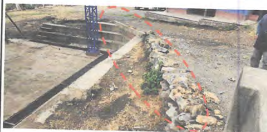
Foto 2: Se levantará pared para muro perimetral.
