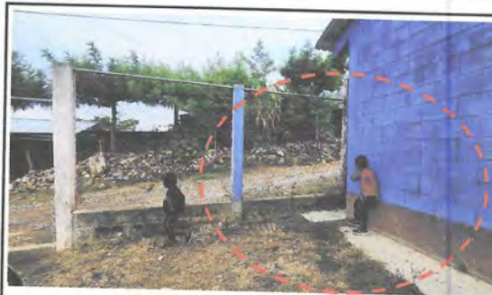
Foto 4: Se levantará pared para muro perimetral.
