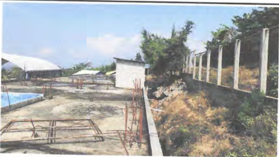
Foto 11: Vista del muro perimetral, en el cual se levantará pared con soleras de refuerzo.
