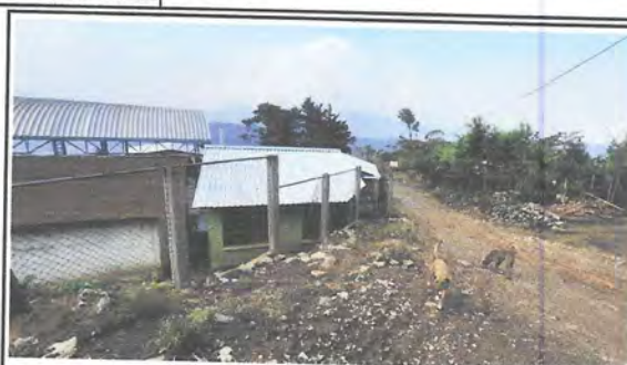
Foto 8: Vista del muro perimetral, en el cual se levantará pared con soleras de refuerzo.
