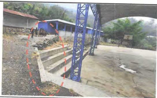
Foto 3: Se levantará pared para muro perimetral.
