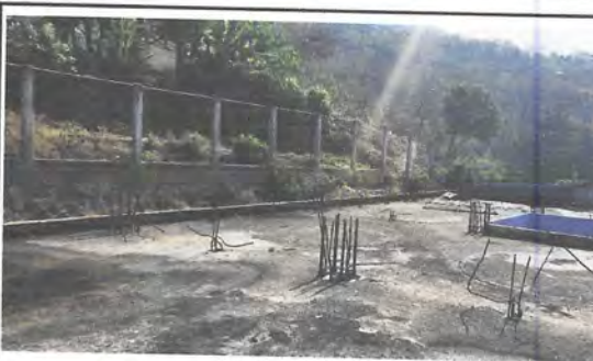
Foto 10: Vista del muro perimetral, en el cual se levantará pared con soleras de refuerzo.
