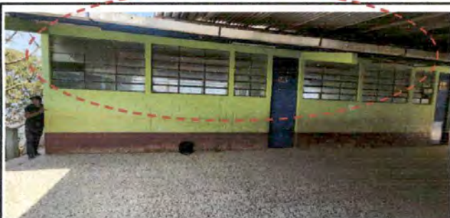
Foto 5: Cambiar canales y colocar bajada de agua pluvial, también de pintara las paredes exteriores e interiores.
