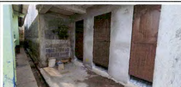
Foto 6: Vista de los baños, se repella y alisa, además se aplicar pintura.
